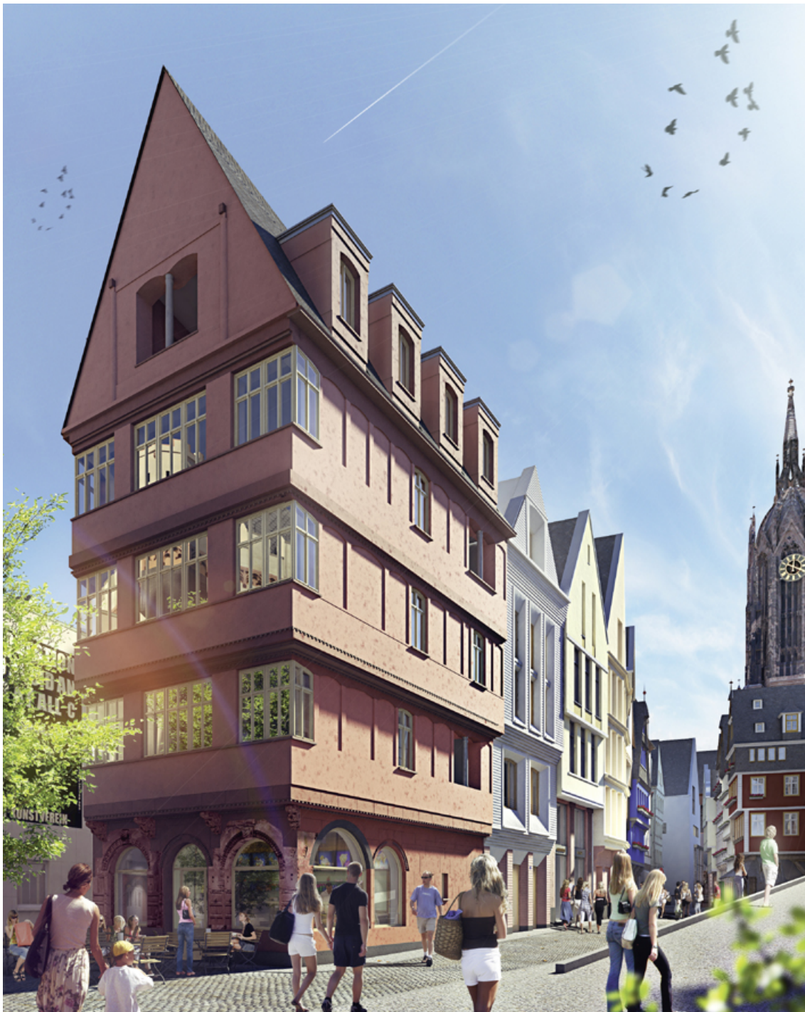
Frankfurt am Main, DomRömer-Quartier (im Bau)
