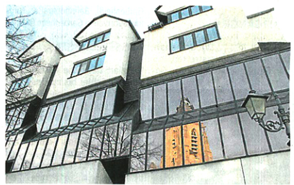
Der Ist-Zustand: In der für die 70er Jahre typischen Spiegelglasfassade des aktuellen Stadthauses am Dom spiegelt sich der Dom. (Foto: Archiv)
